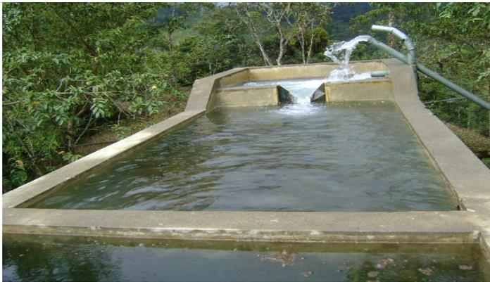
*Figura 2.5: Tanque de filtrado grueso*
