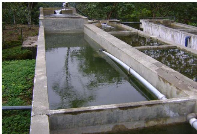
*Figura 2.7: Tanque de filtrado lento en arena*
