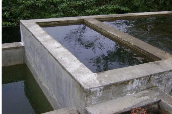
*Figura 2.6: Tanque sedimentador*
