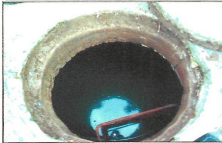
Imagen N° 3.10.- Aguas estancadas en el interior de un tanaue colector inoüerante.
