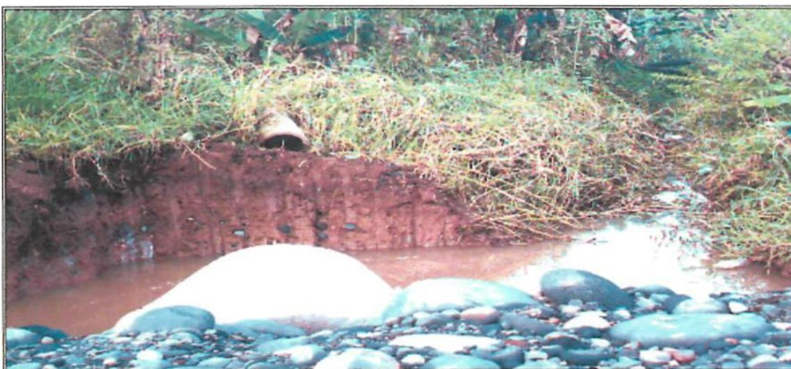
Imagen N<sup>2</sup> 3.17.- Aguas estancadas y descarga de residuales líquidos en el Sector "La Isla"
