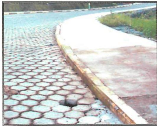
Imagen N<sup>2</sup> 3.16.- Muros de gaviales construidos en la zona y hundimiento del Adoquinado de las Calles del Sector.
