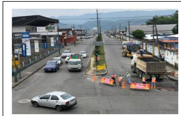
Figura 18. Avenida Alberto Zambrano de la ciudad de Puyo, con poca presencia de arbolado urbano
