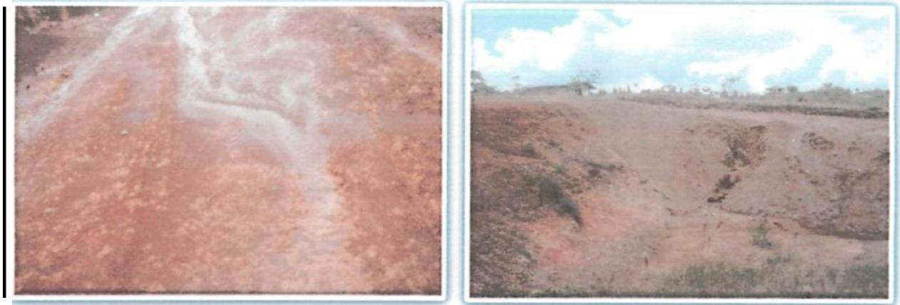
**Imagen 6,** Erosión producto del arrastre de las aguas
