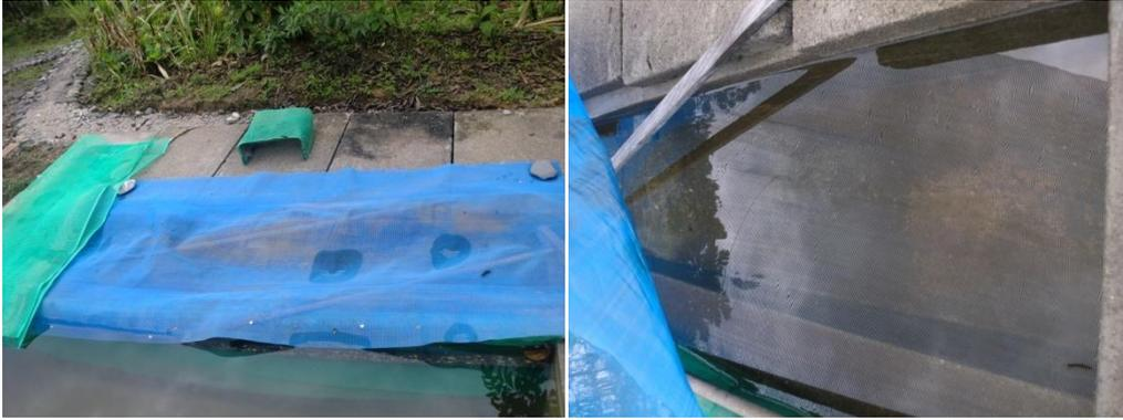
**Figura 3.** Salida del agua tratada del tanque de sedimentación, cubierta con malla para que ingresen insectos y asuras.
