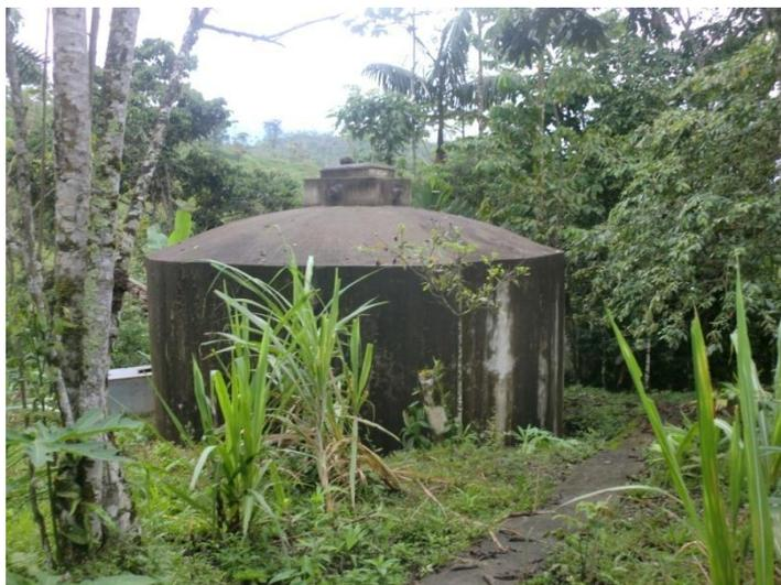
**Figura 5.** Tanque de almacenamiento del agua tratada.
