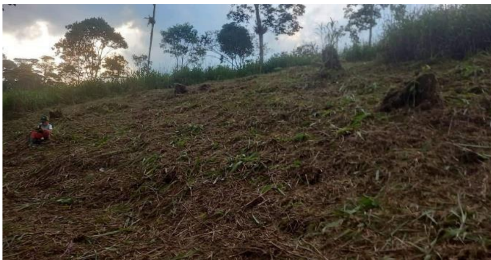
Figura 2: Limpieza del terreno
