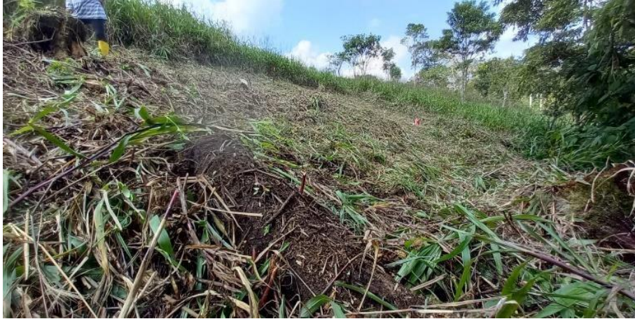
Figura 2: Limpieza del terreno
