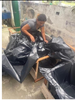
Colocación de geomembra hdp
