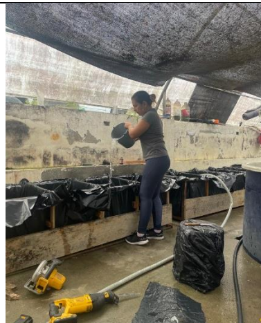
Llenado de tanques
