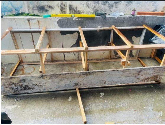
Construcción de armazones de madera
