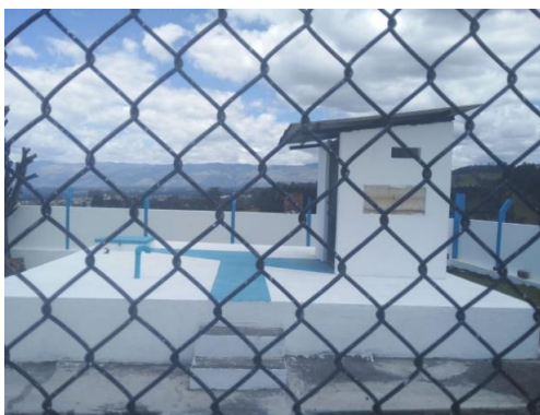
Figura 17. Depósito de agua - San Juan
