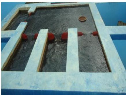
Figura 14. Vertederos de la Planta Potabilizadora del cantón Palora.
