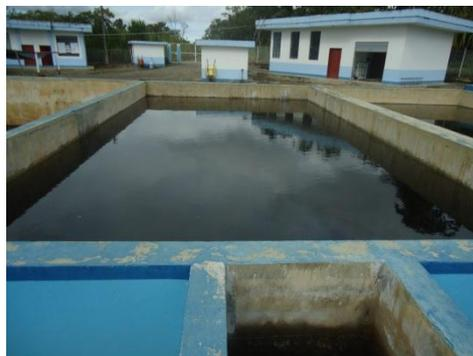
Figura 15. Uno de los cuatro filtros lentos de la Planta Potabilizadora del cantón Palora.
