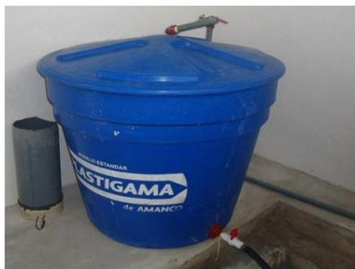
Figura 19. Hipoclorador de 500 l en la Planta Potabilizadora del cantón Palora.
