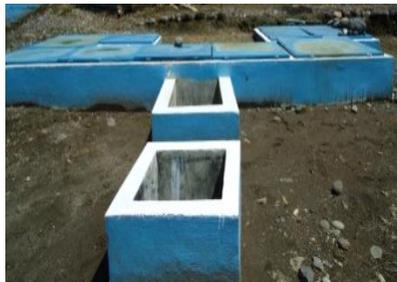
Figura 9. Desarenador de la Planta Potabilizadora del cantón Palora.
