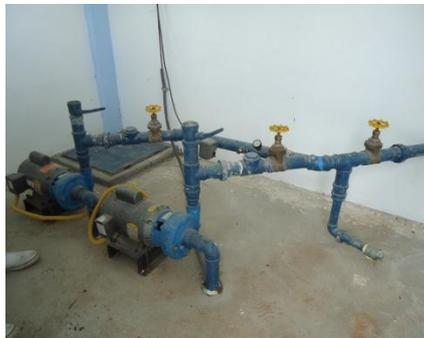
Figura 22. Bombas de la PTAP de la Planta Potabilizadora del cantón Palora.
