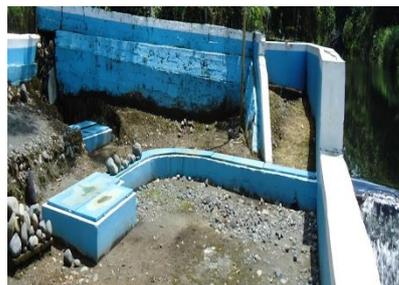
Figura 8. Canal abierto y deripador de la Planta Potabilizadora del cantón Palora
