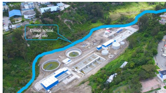
Figura 7. Geofoma Terraza baja y cauce actual
