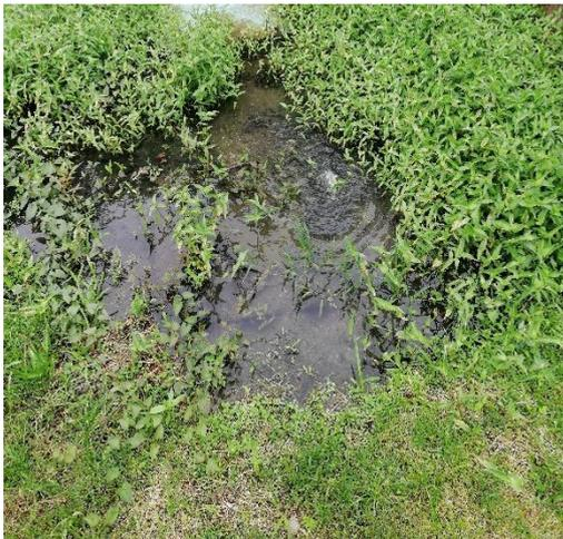
**Fotografía 8.2.** Rebose del agua sobre la fosa séptica.
