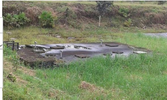
**Figura 8.** Fosa Séptica de la PTAR
