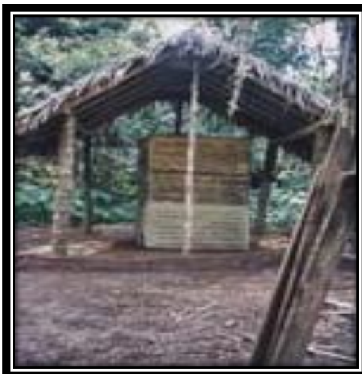
Figura: N° 12. Inodoro seco en la comunidad Sharamentsa
