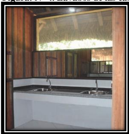
Figura: N° 4. Lavabos de las cabañas
