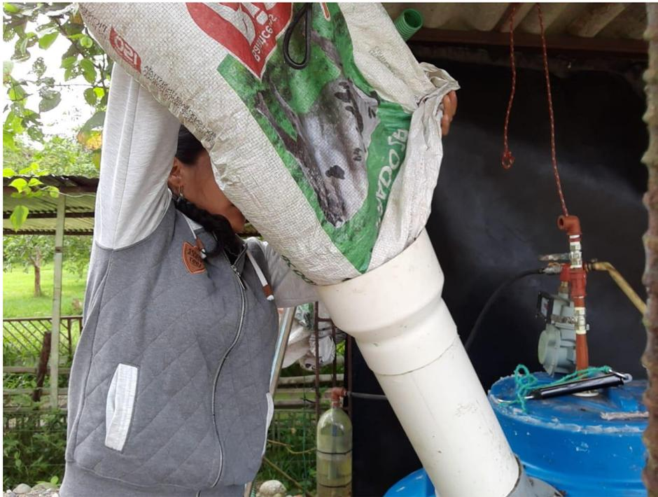
Figura 6. Primera carga del biodigestor moderno.
