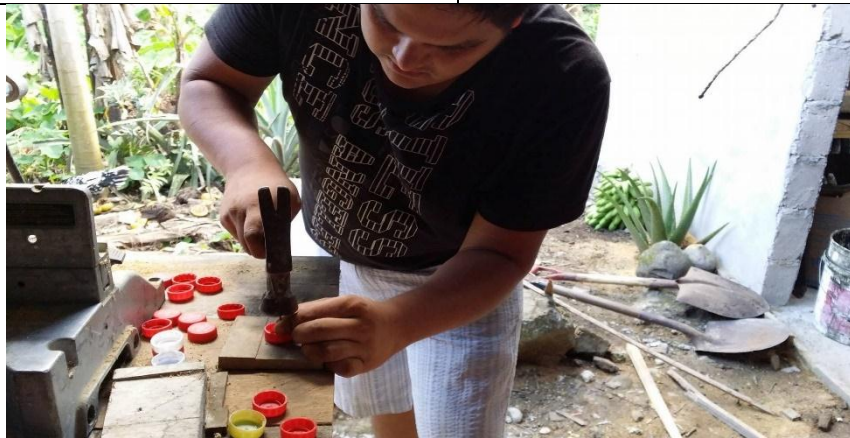
ANEX.FOT 10. ELABORACIÓN PARA COLOCACIÓN DE GANCHOS.
