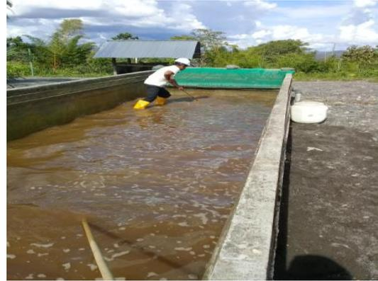
**Fotografía 9.** Desinfección de las paredes del filtro.
