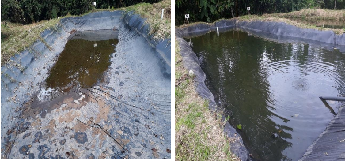
Foto 1. Limpieza y desinfección de los estanques con geomembrana
