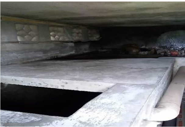
Fotografía 3.- Captación de la unión de las 2 vertientes.
