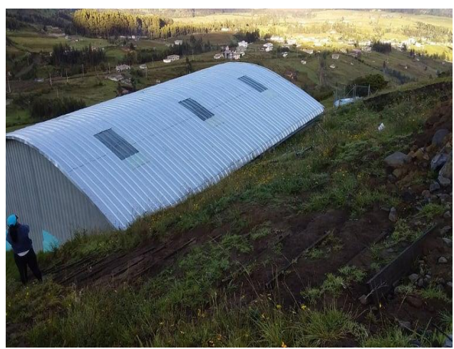
Fotografía 12.- Vista exterior de la PTAP.
