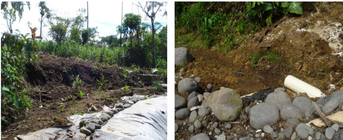
Imagen 3.8 y 3.9: Falta de drenaje pluvial en las áreas del Relleno Sanitario.
