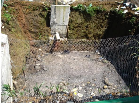
**Imagen 3.13:** Tanque colector sin protección ni impermeabilización.
