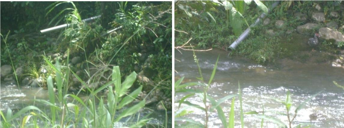
**Imágenes 3.4 y 3.5: Tuberías de descarga de aguas residuales que van directo de las Viviendas hasta el río Pambay.**
