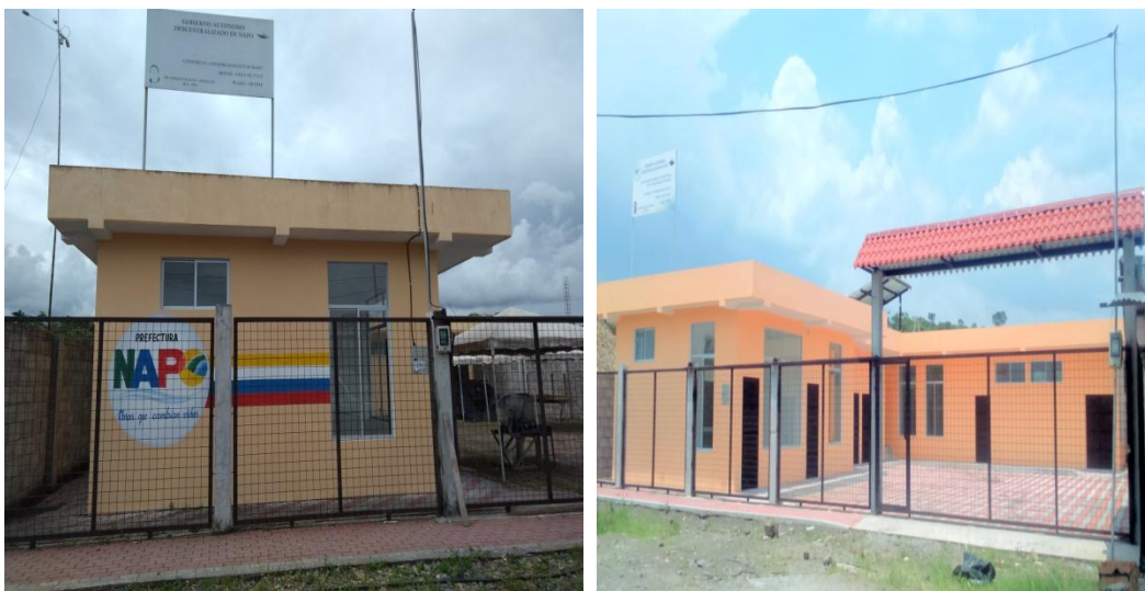
Instalaciones físicas de la planta de procesamiento en la comunidad de Wamani – Hatun Sumaco.
