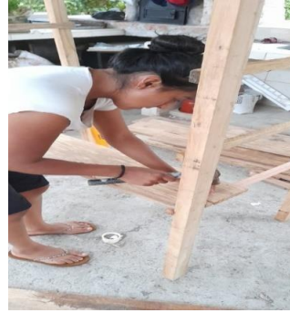
Figura 23 Construcción de Bastidores
