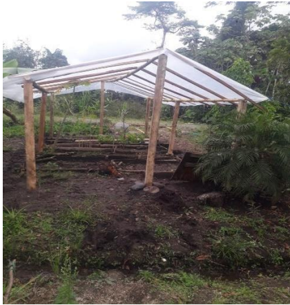
Montaje del invernadero
