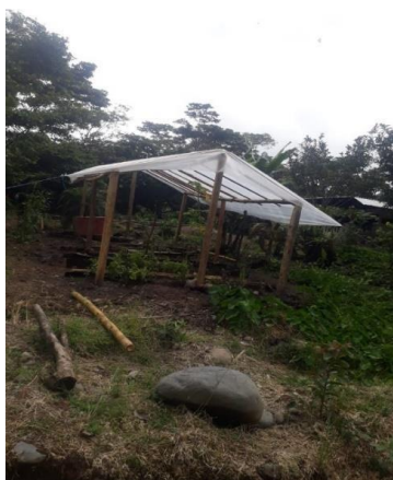
Figura 19 Construcción de invernadero
