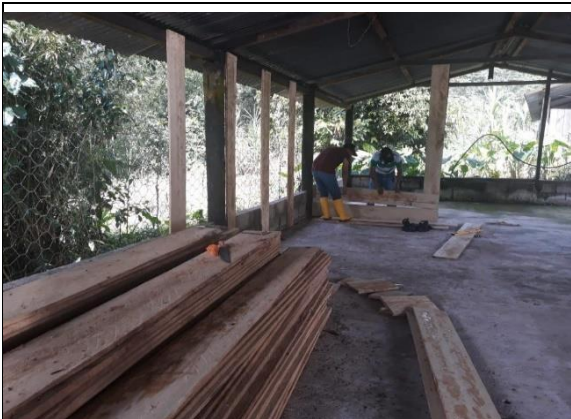
Ilustración 5: Acondicionamiento de galpones
