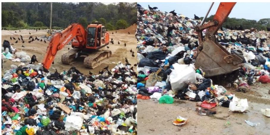
**Figura 12:** *Homogenización de los desechos ingresados previos a toma de muestras.*
