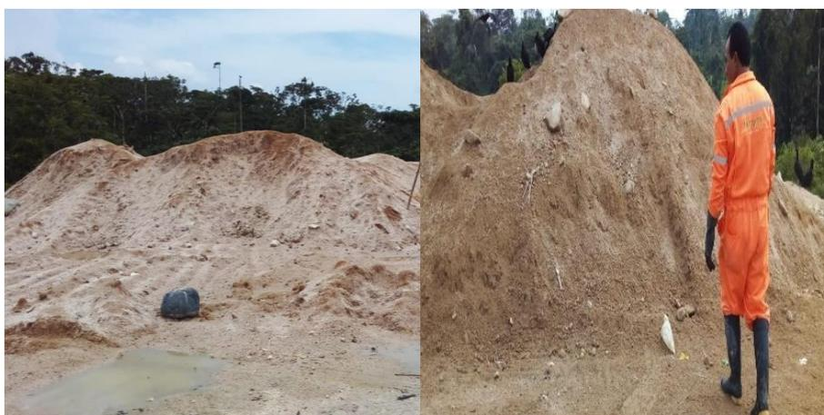
**Figura 10:** *Sitio de Acopio de material para cobertura o recubrimiento diario.*
