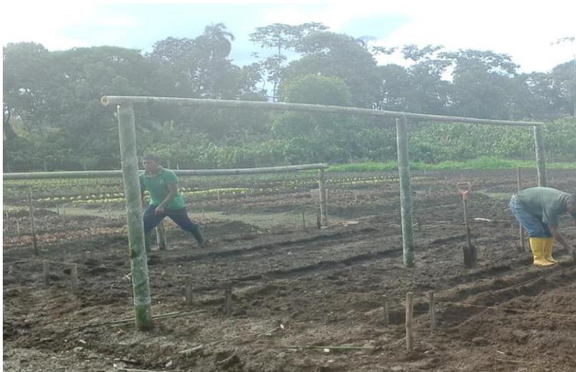
Anexo 2. Recolección y construcción de la cámara térmica con material de caña guadua, para la colocación del plástico de invernadero.
