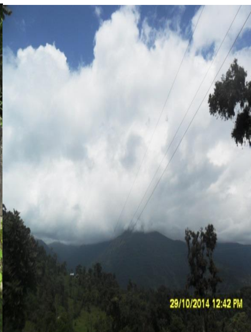
Imagen 7. Tendido de Redes eléctricas que paso por la zona.
