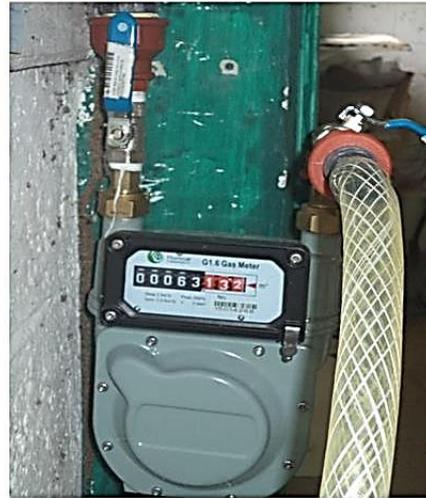
Figura 7. Utilización de los gasómetros para la medición diaria del biogás producido.
