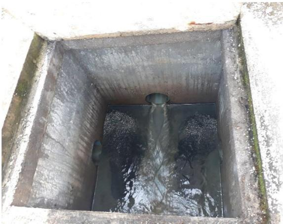
*Presencia de arenas en el cajón distribuidor*
