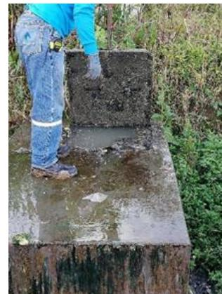
*Colpasado del tanque desarenador*
