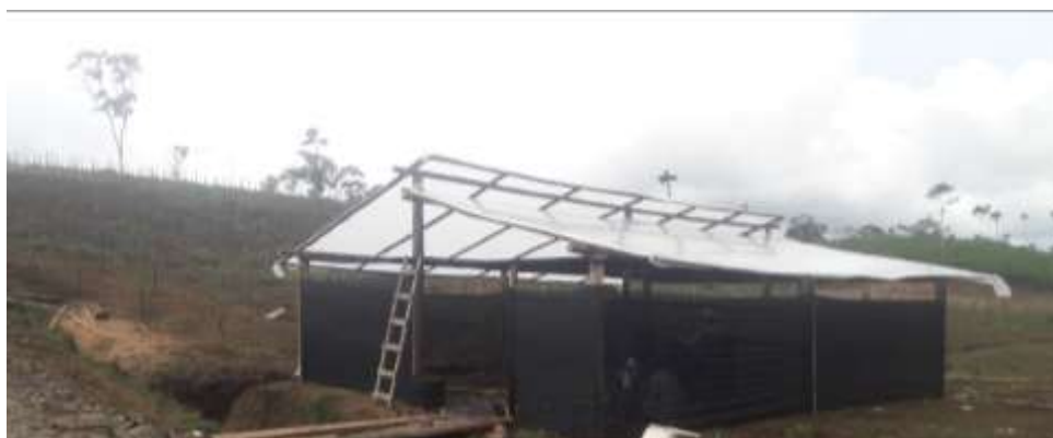
Figura 10: Construcción del invernadero.
