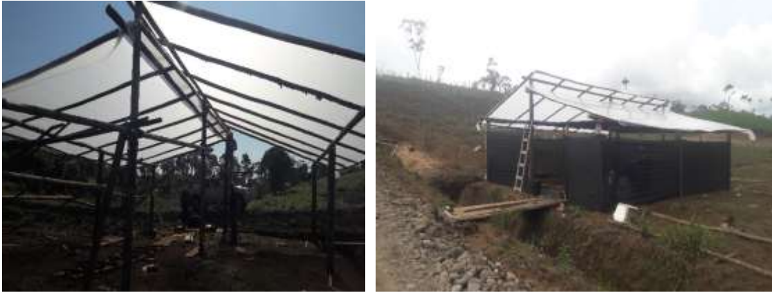
Figura 1: Construcción del invernadero
