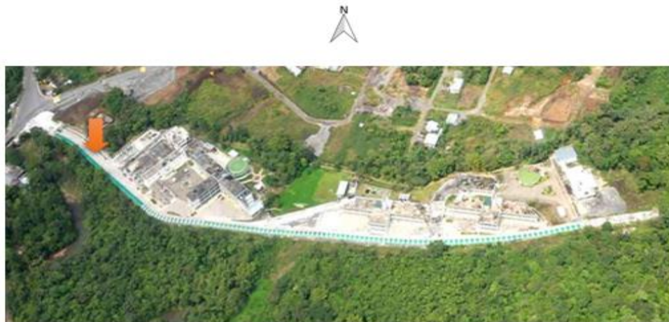
Figura 3. Fotografía de Dron con vista superior de la UEA
