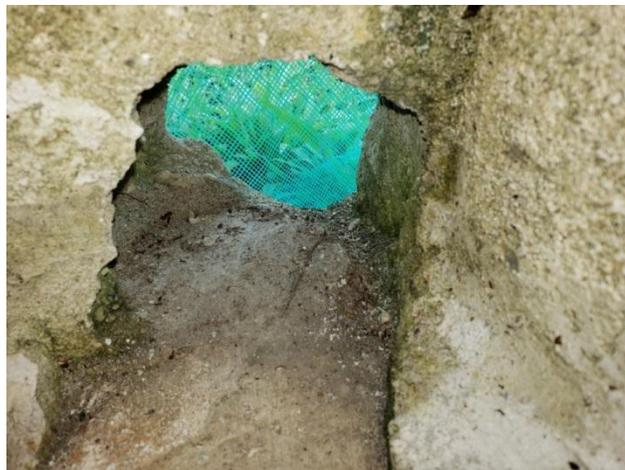
*Figura 18. Drenaje de la marquesina cubierto con malla*
