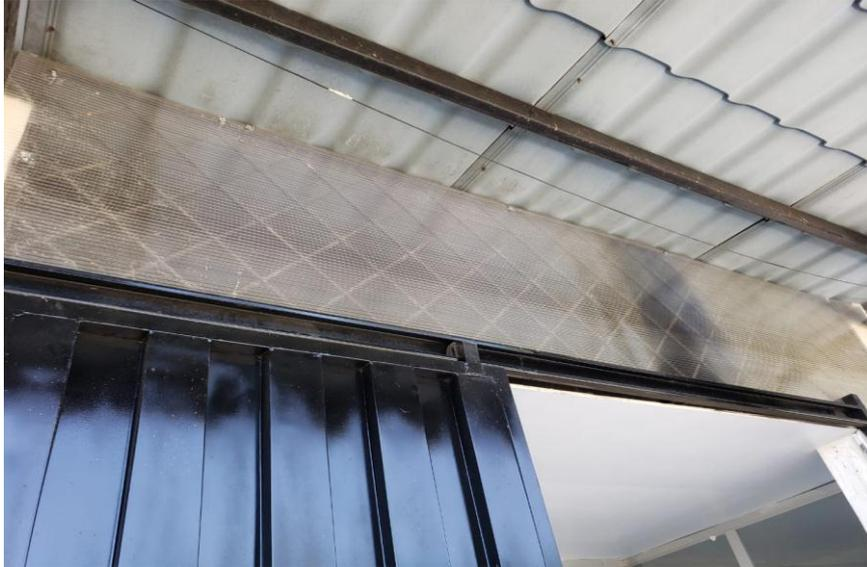
*Figura 19. Policarbonato colocado en el área de tostado y almacenamiento de cacao*
