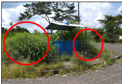
Ilustración 24: Falta de limpieza de la cobertura vegetal.
