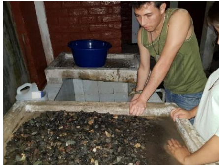
Imagen 8. Lavado de grava.
