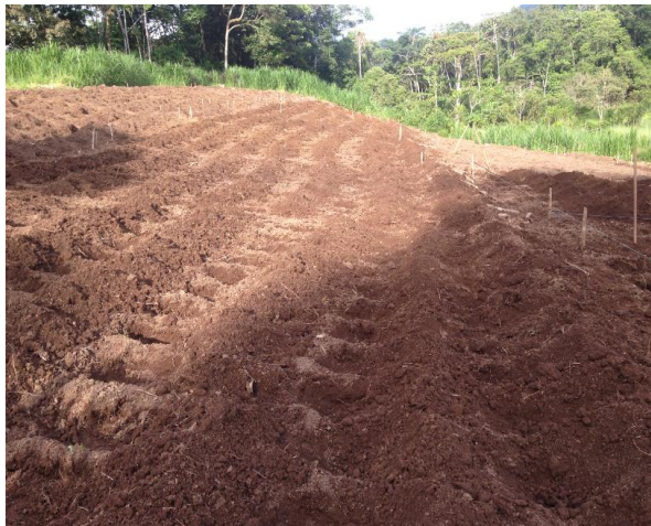
Construcción de terrazas
