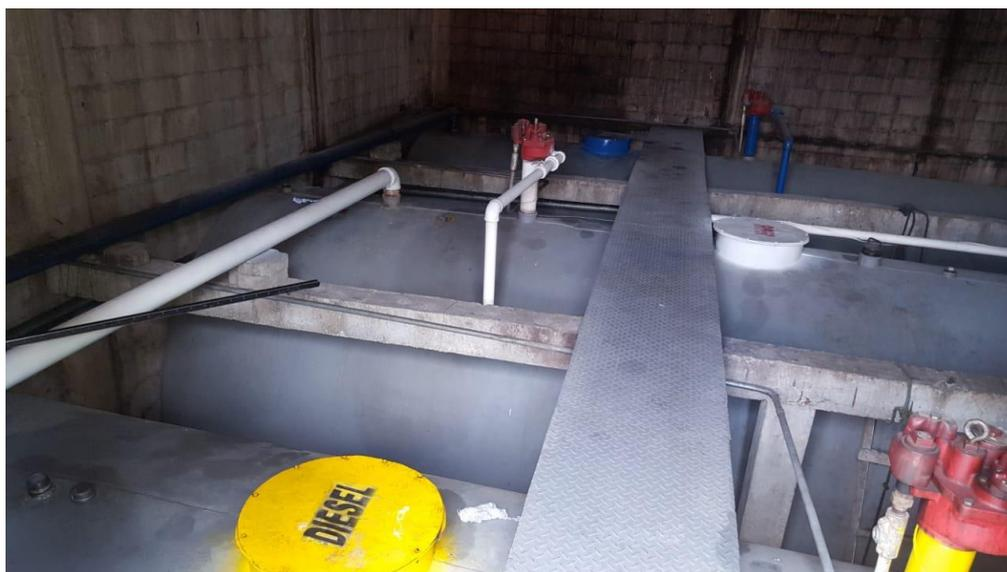
**Fotografía 4.** Tanques de almacenamiento de combustible
