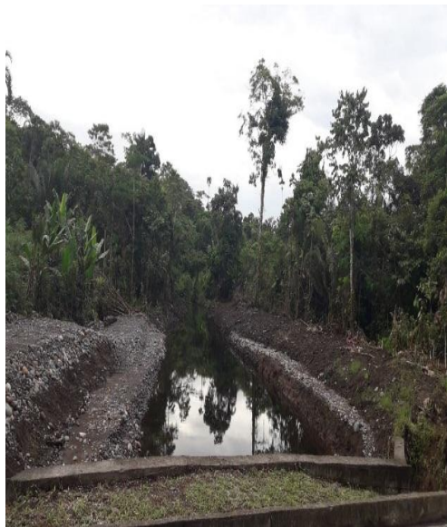
Ilustración 0-3 Dique Yana Rumi Fuente: Autores
