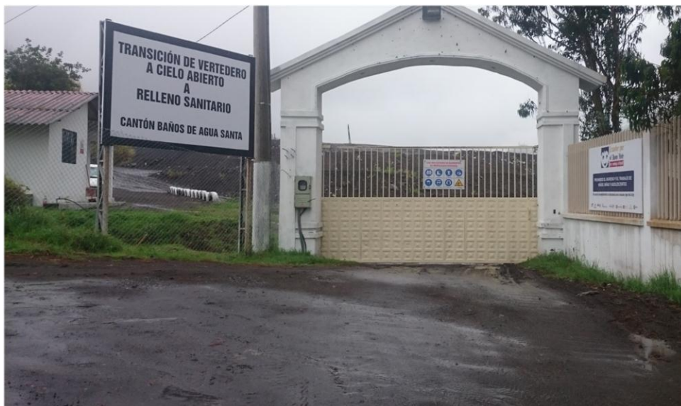
Figura 3.- Presencia del relleno sanitario.
