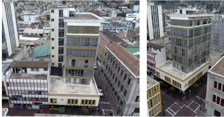
Figura 3. Instalaciones del Gobierno Provincial de Tungurahua, calles Bolívar y Castillo, Ambato
